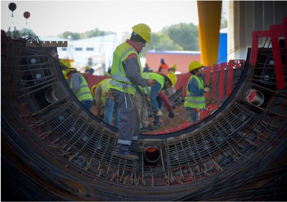
Fábrica de torres de hormigón - Foto Juan Corral – Gentileza Municipalidad de Bahía Blanca
